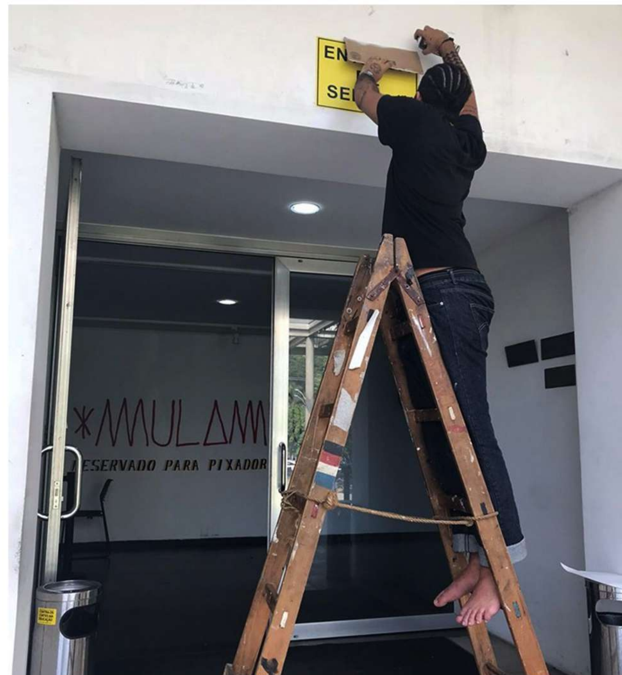
Colocando a placa de 'Entrada de Serviço'
